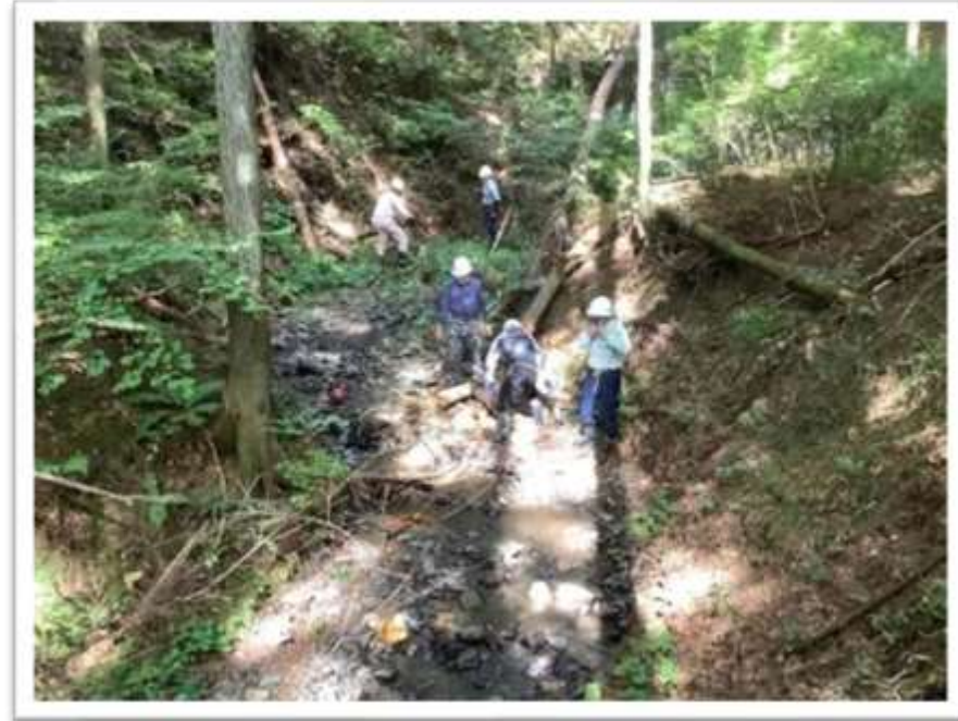
区民により撤去作業
